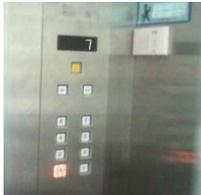
系统预留与使用单位的电梯控制系统对接的功能，根据电梯控制系统接口二次定制开发后，可实现发放给来访人员的电梯卡与来访人员信息相互匹配的功能。
